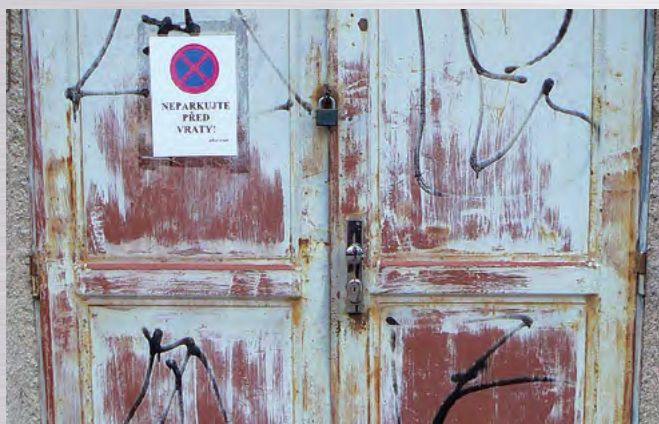
Stav před montáží
