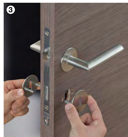
V případě potřeby zasuňte klíčové rozety do sebe – a hotovo!
